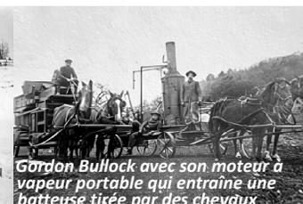
**Gordon Bullock avec son moteur à vapeur portable qui entraîne une batteuse tirée par des chevaux**
